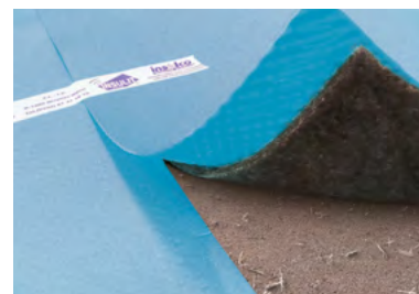
Dérouler l'insulit 4+2 avec un recouvrement de 5 à 10 cm
