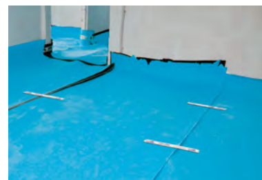
Remonter de ±15 cm contre les murs avant de réaliser la chape
